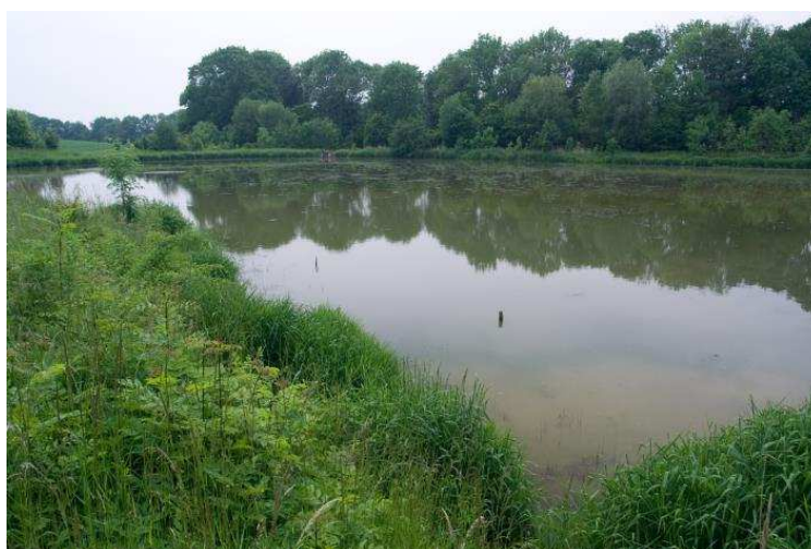
Příklad stabilizační nádrže po více než 15 letech provozu (autor: Dr.Michal Kriška)
