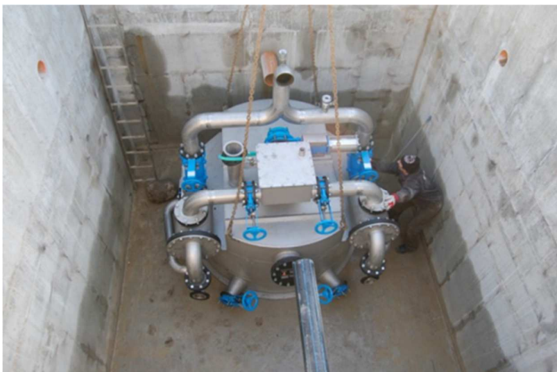
Obr. Suchá čerpací stanice – montáž
