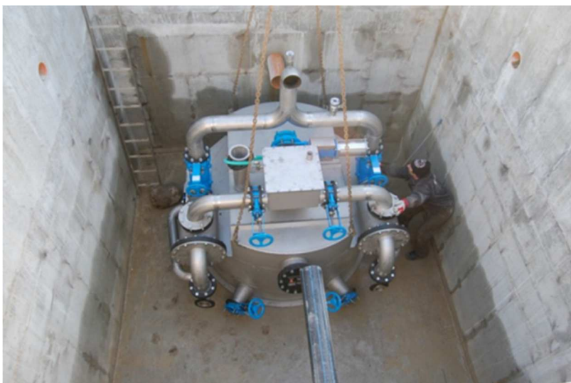
Obr. Suchá čerpací stanice – montáž
